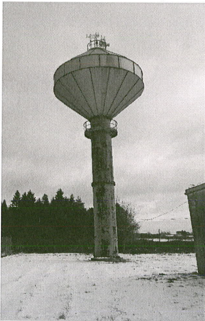
Ilustracja 1 Istniejąca wieża ciśnień
